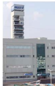
Testy długości instalacji
